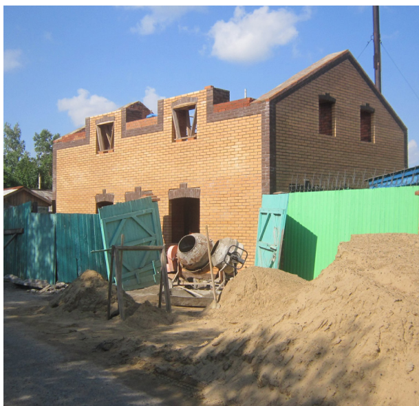
Строительство храма Александра Невского
